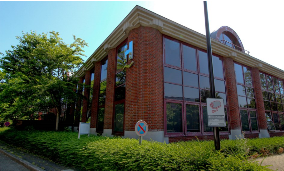
Zicht op gebouw H
