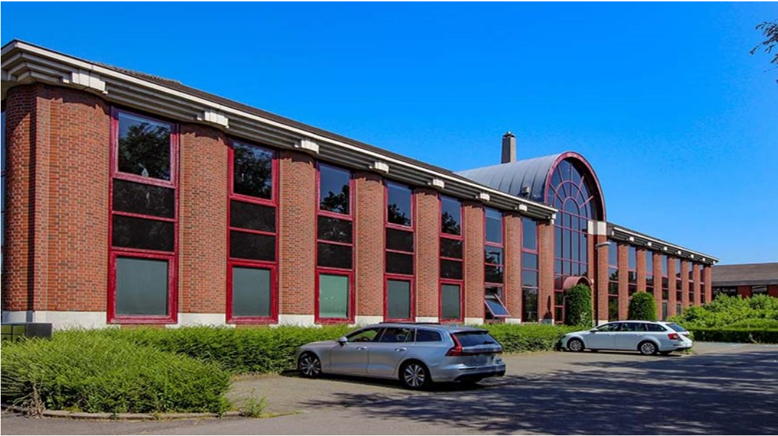
Vue de l'immeuble H
